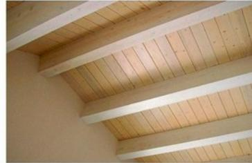
Imm.02 - Esempio di vista interta di un sottotetto realizzato in legno lamellare (i colori non sono indicativi ai fini del progetto)
