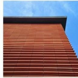
Imm.05- Esempio di facciata frangisole in cotto dello stesso tipo previsto in progetto (edificio poste di Ascona)
